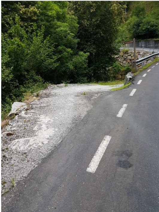
Imatge 03. Estat actual del camí d'accés al disseminat de Navias.
