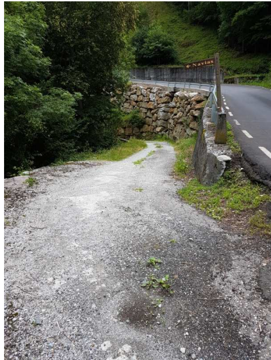
Imatge 04. Estat actual del camí d'accés al disseminat de Navias.
